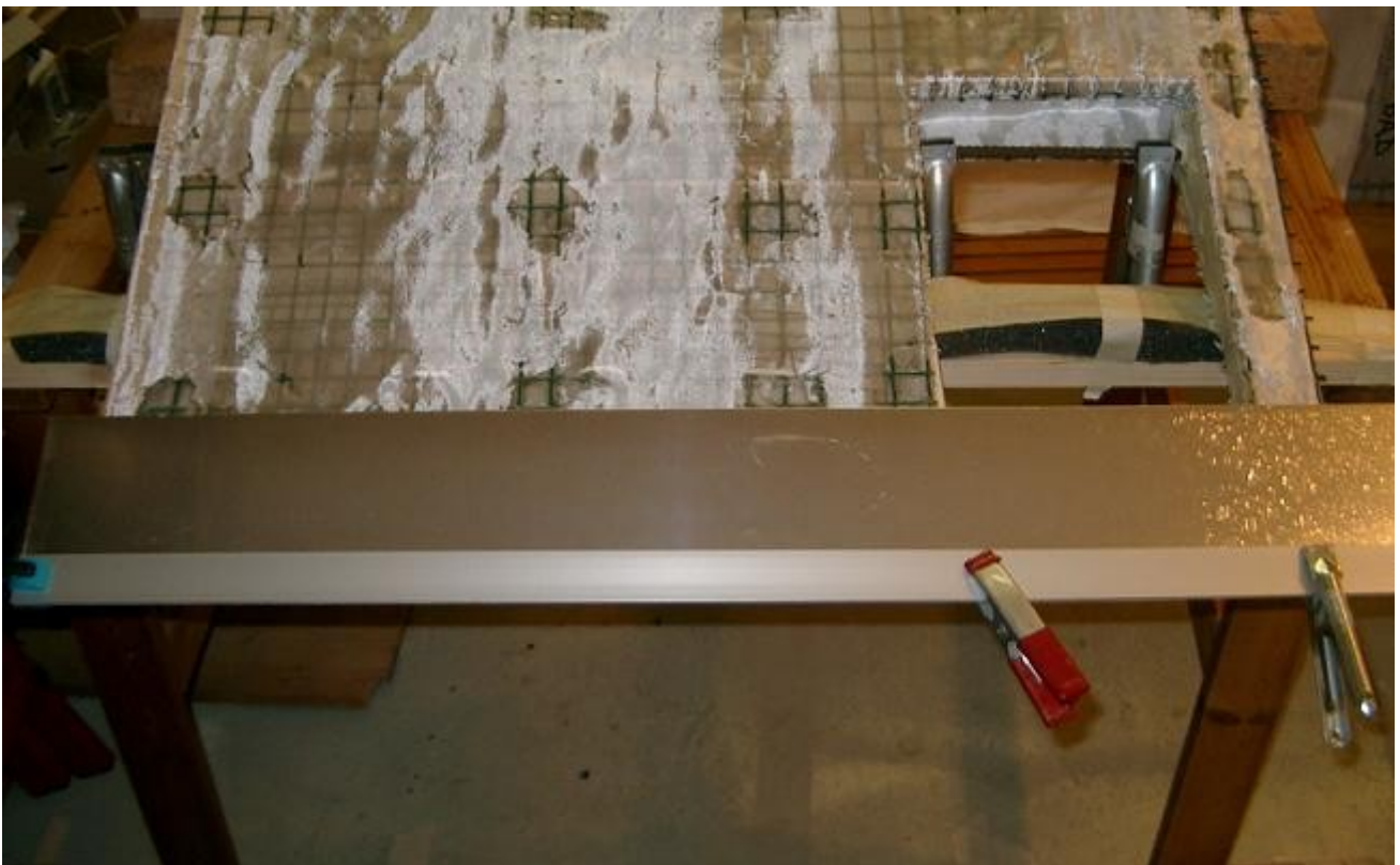
Zur Stabilisation durch die Hilfsholm-Öffnung ein Armierungseisen gesteckt; die Auflage-Latte mit Schaumstoff gepolstert und mit Alu-Flachprofilen oben (unten mit einem Winkelprofil) den Flügel-Teil für das Umlegen vom Alu-Dünnband vorbereitet (schmale Hartholz-Latten qualifizieren auch).
